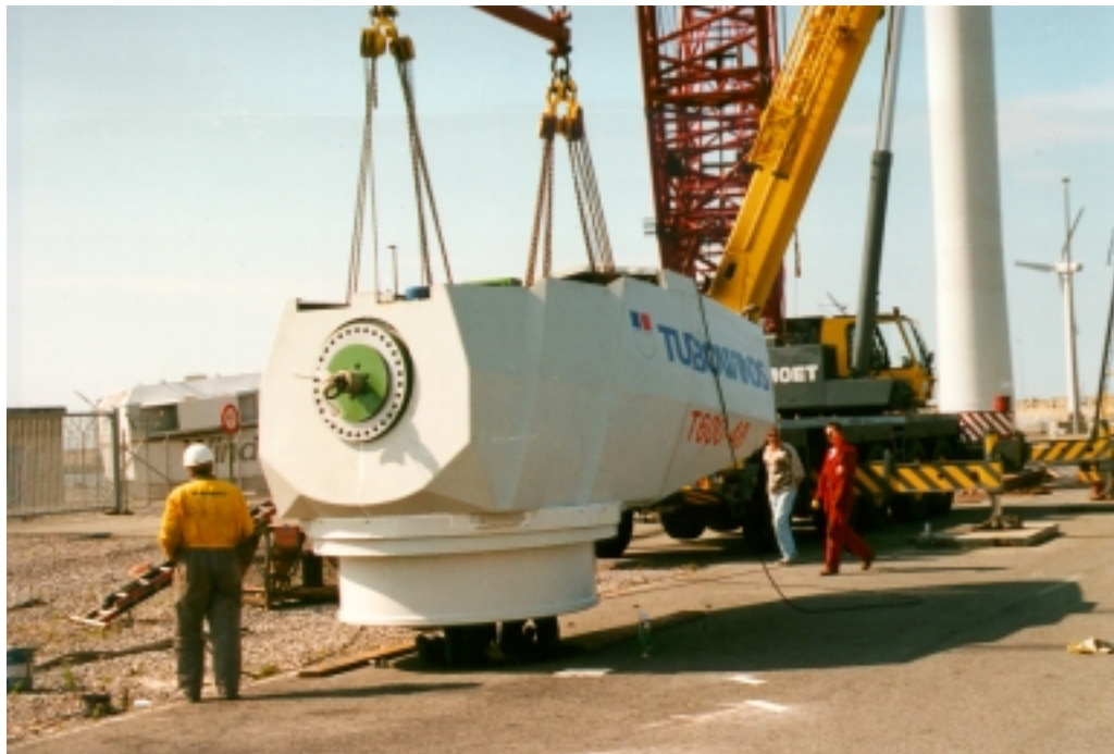
Foto 5: Een gondel van een 600 kW machine, klaar om gehesen te worden. Het gewicht van een gondel met machinerie bedraagt ongeveer 25 ton. (Foto: Vrije Universiteit Brussel)
