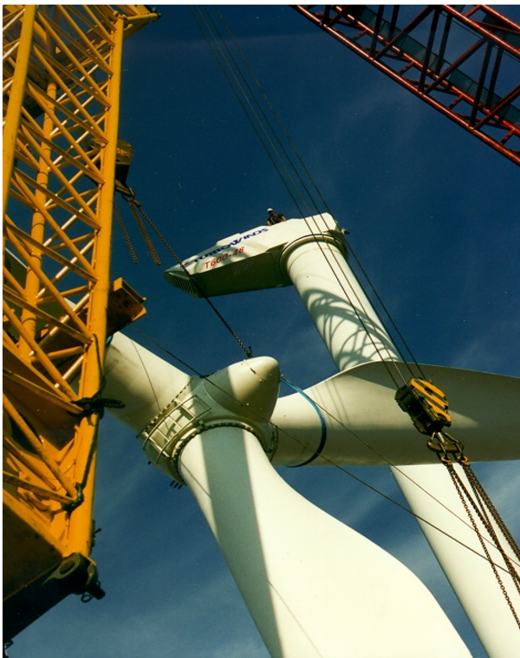
Foto 16: De oprichting van een 600 KW turbine in Zeebrugge. Zware kranen komen eraan te pas om de rotor van 48 m diameter 60 meter hoog te hijsen. (Foto: Yseult de Crombrughe)
