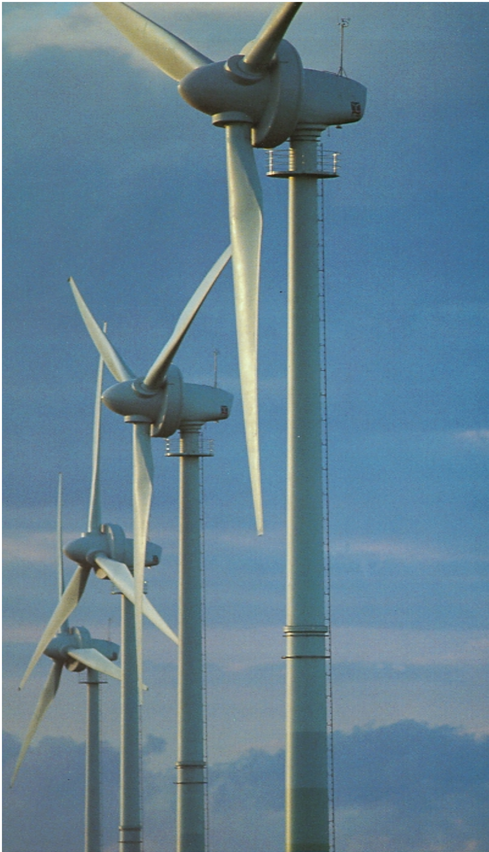
Foto 8: Windturbine met direct aangedreven generator, herkenbaar aan de grote ring geplaatst achter de naaf. (Foto: ENERCON Duitsland)
