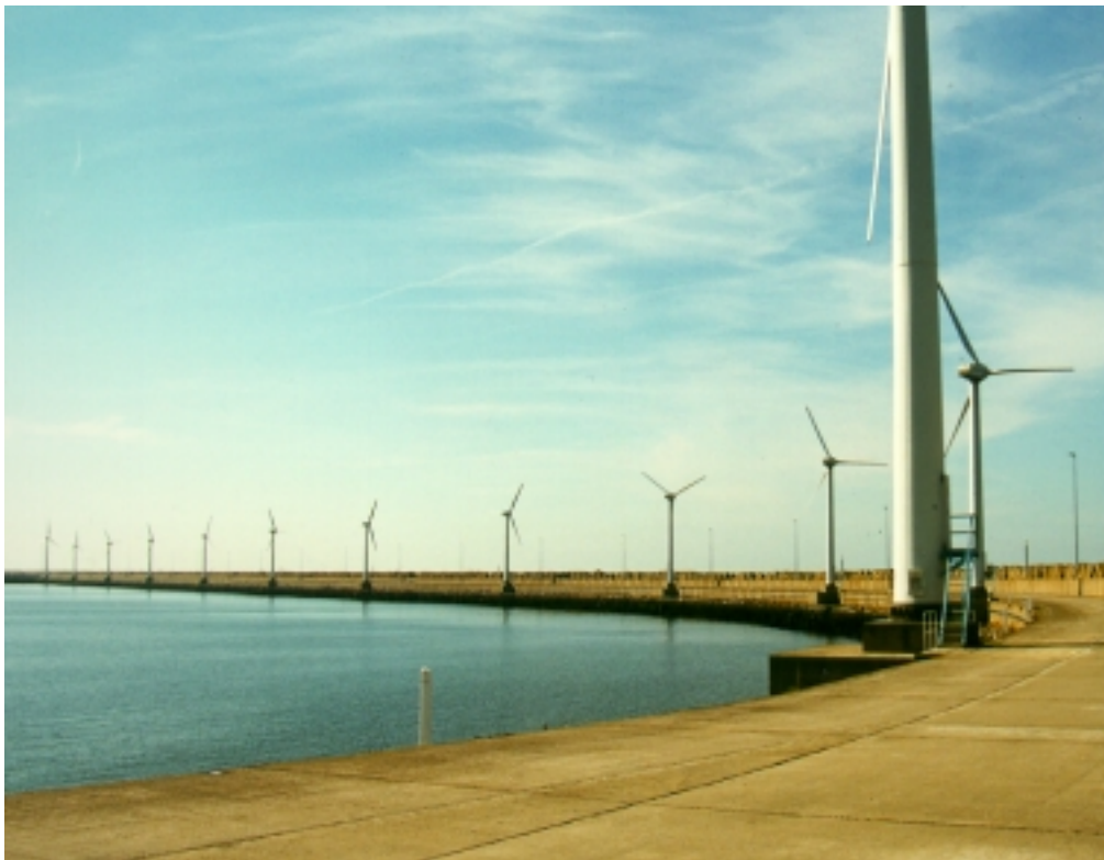
Foto 11: Het windpark in Zeebrugge werd in 1986 gebouwd onder stimulans van het toenmalig Ministerie van Openbare Werken. Het was één van de eerste windparken in Europa. Het wordt nu uitgebaat door INTERELECTRA. (Foto:Yseult de Crombrughe)
