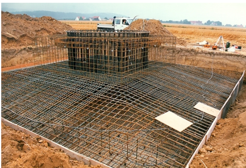
Foto 15: De fundering van een 1.000 kW windturbine. Het funderingsmassief bestaat uit 200 m 3 beton en 20 ton staal.
