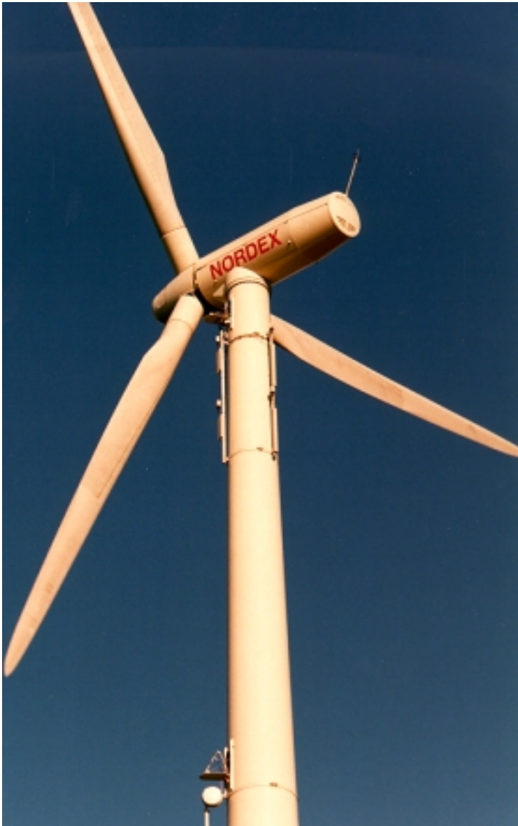
Foto 13: Windturbine met zendinstallatie voor mobiele telefonie (foto: Nordex windturbines)
