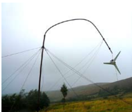
Fig. 57: Broken guy wires
