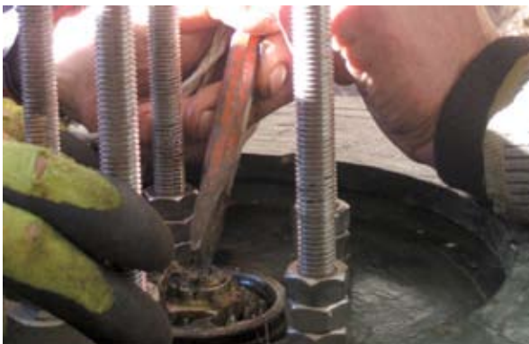
Fig. 41: Lock the nut
